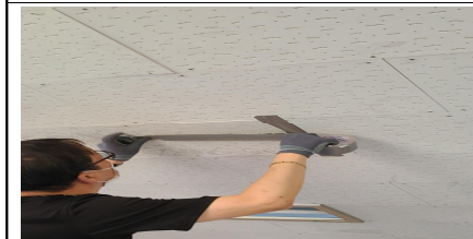
시설 주무관님과과의 보수 작업 1
