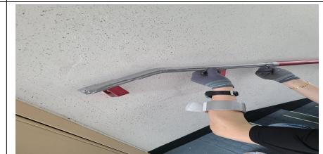
시설 주무관님과과의 보수 작업 2
